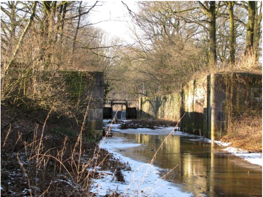
Ingang sluis Neersebrug
